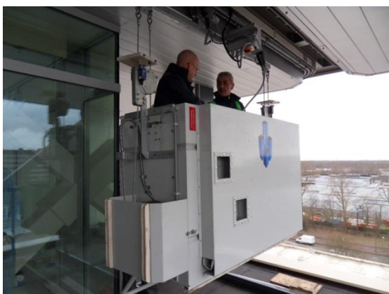
Gondel aan een railwagen in een monorailsysteem
