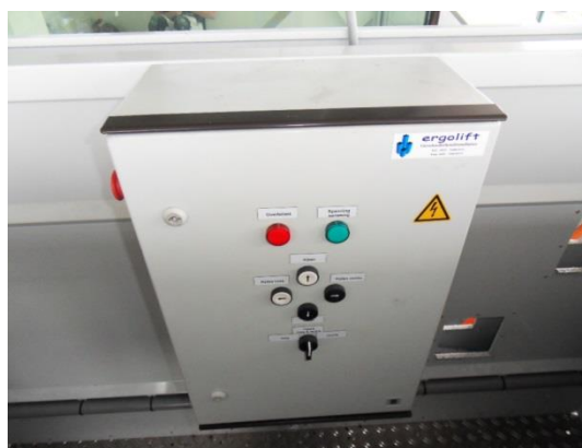
Bedienings-/besturingskast in de gondel
